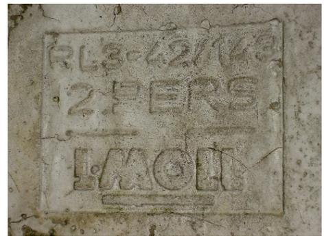
*Typen- und Zulassungsbezeichnung an der Splitterschutzzelle*
