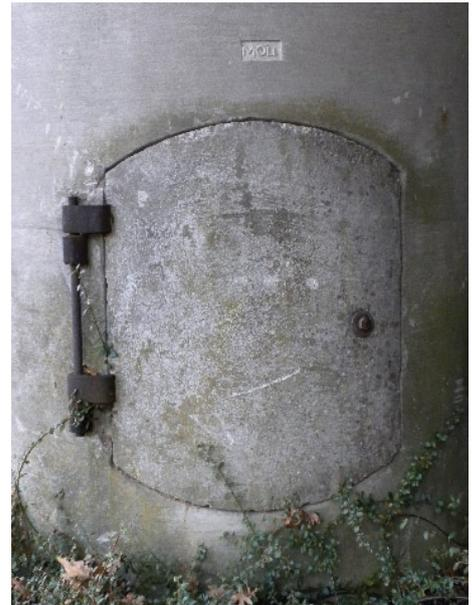
*eine der beiden Zugangstüren in die Splitterschutzzelle*
