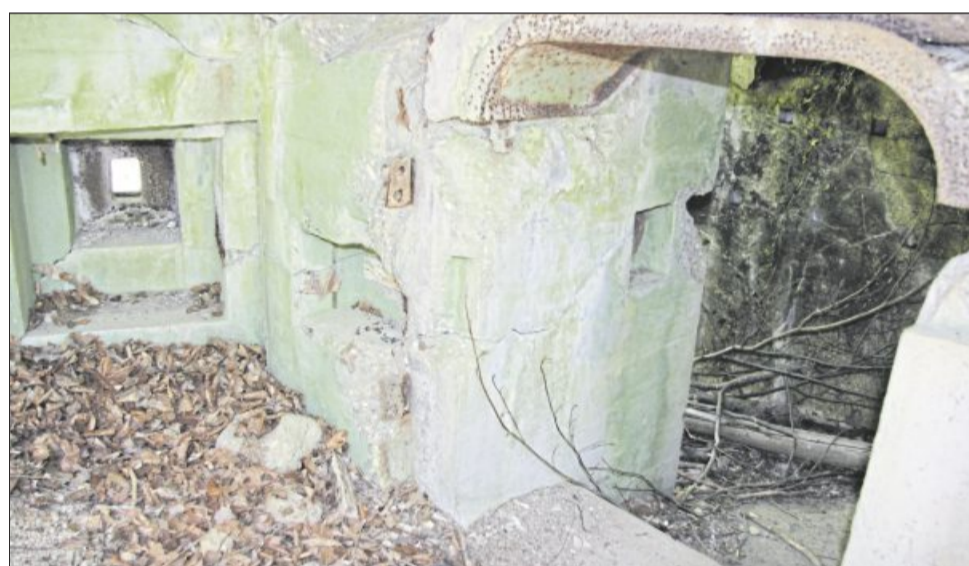
Der Bunkereingang samt Schießscharte von außen gesehen.
