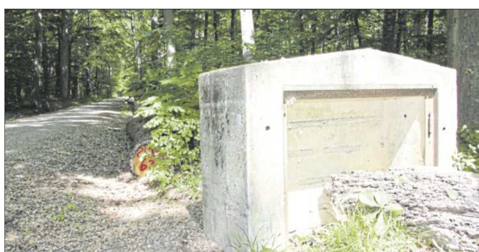
Eine Kabelsäule hinter der Bunkerlinie diente einst zur Kommunikation des Regimentsgefechtsstandes mit den Bunkerbesatzungen.
